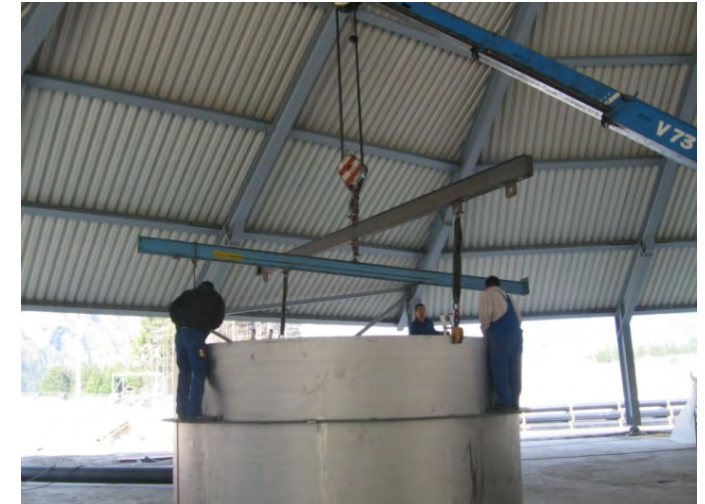
Сборка на строительной площадке и монтаж (Австрия) Выпарной кристаллизатор \varnothing 6.400 мм, общая длина 18.700 мм, 56 т, 1.4562
