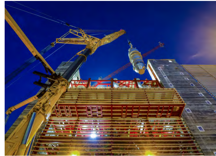
Теплообменники Ø 3.100 мм, общая длина 17.640 мм, вес 113 т Транспорт при помощи специального транспорта на воздушных подушках
