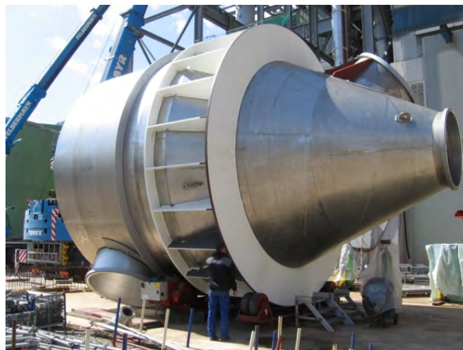
Сборка на строительной площадке и монтаж (Австрия) Выпарной кристаллизатор \varnothing 6.400 мм, общая длина 18.700 мм, 56 т, 1.4562
