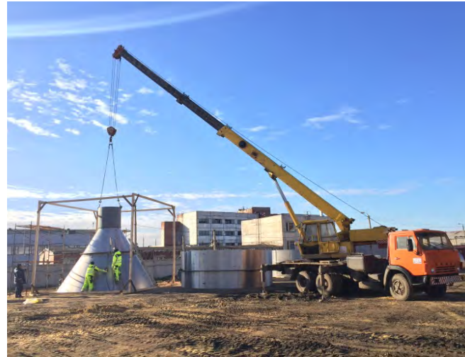
Сборка на строительной площадке и монтаж (Россия) Выпарной кристаллизатор Ø 5.400 мм, общая длина 21.800 мм, 40 т, 1.4562
