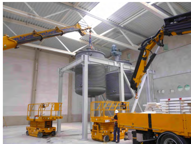
Изготовление и монтаж емкостей с мешалкой вкл. КИП (Германия) Ø 2.200 мм - Ø 3.000 мм, общая высота 5.700 мм, вес 7 - 11,6 т, сталь
