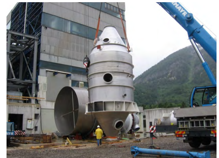
Сборка на строительной площадке и монтаж (Австрия) Выпарной кристаллизатор \varnothing 6.400 мм, общая длина 18.700 мм, 56 т, 1.4562
