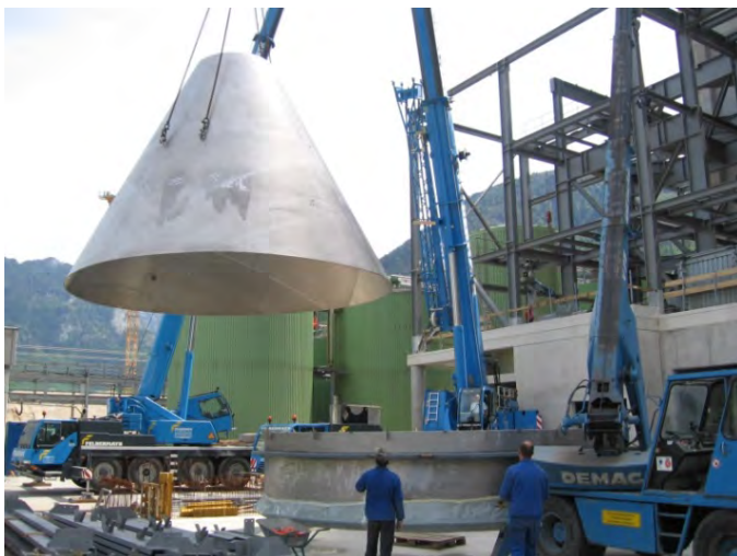
Сборка на строительной площадке и монтаж (Австрия) Выпарной кристаллизатор \varnothing 6.400 мм, общая длина 18.700 мм, 56 т, 1.4562
